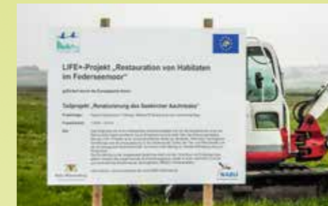
Bautafel „Renaturierung Seekircher Aachried“ / Board “Renaturation of Seekircher Aachried“
