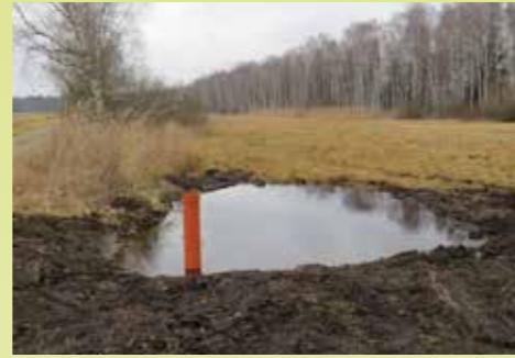
Rohrstau / Pipe blockage
