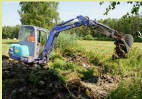
Grabenverschluss / Ditch closure
