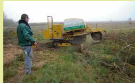
Fräsen der Baumstumpen / Cutting of tree stumps
