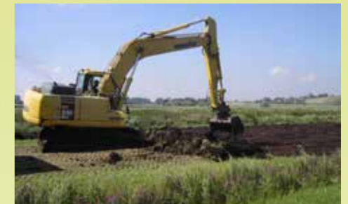
Abschieben der obersten vererdeten Torfschicht / Pushing off the earthy soil
