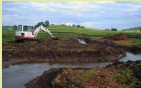
Anlage des neuen Betts der Seekircher Aach / New, raised river bed of the Seekircher Aach
