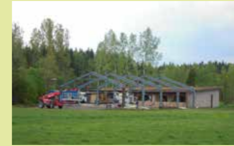
Abbruch Gebäude / Demolition of the building
